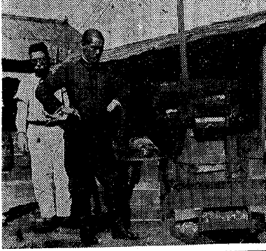
代燃工場の内部の様子
